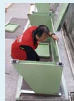
▲即使下著大雨，依舊專業快速組裝定位完成
