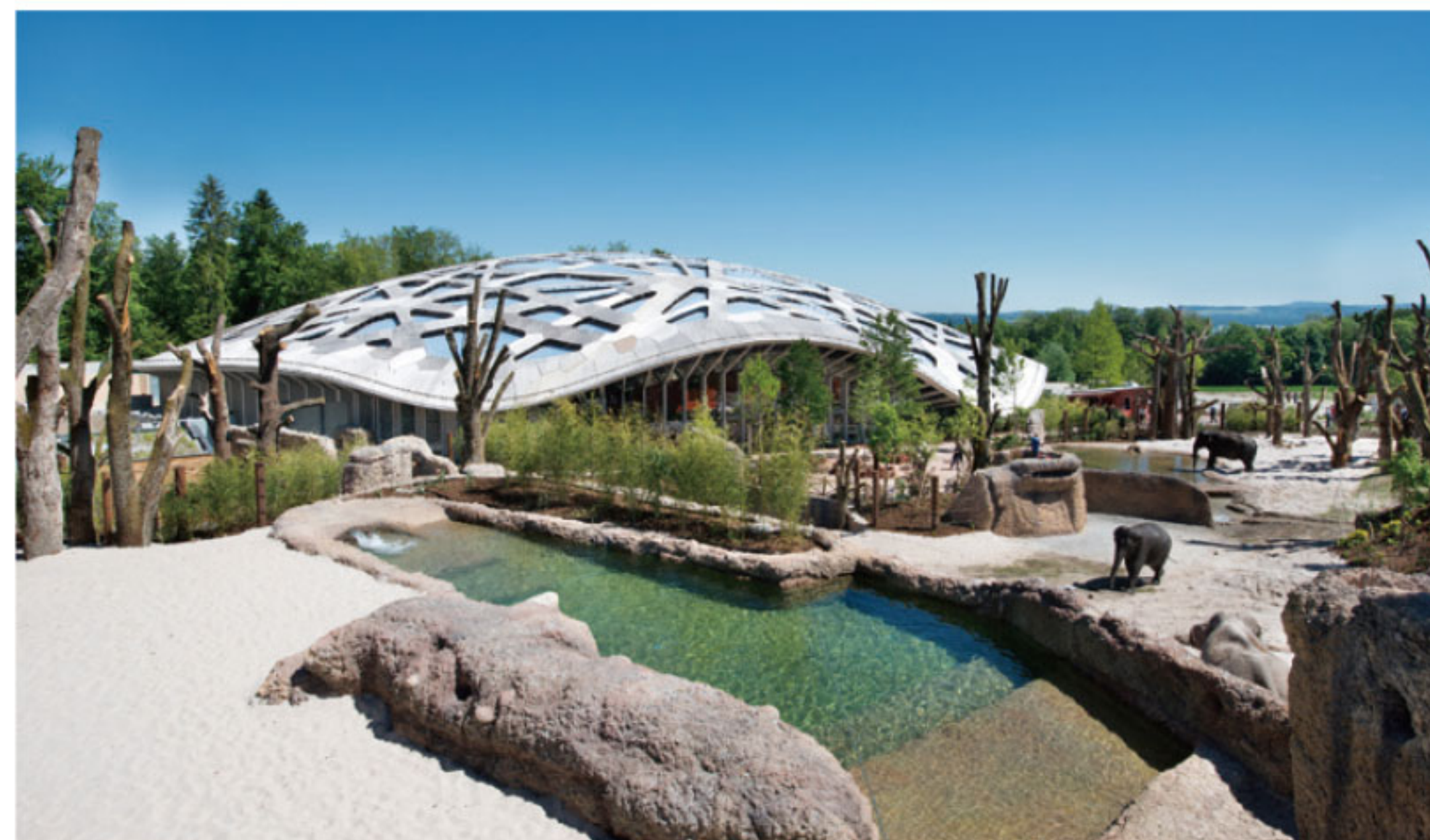
木建築不只被用於住宅，也開始應用在公共建築，瑞士蘇黎世動物園的大象館，便別出心裁使用大跨距的木構天幕，為象群營造充滿自然氣息的生活環境。
