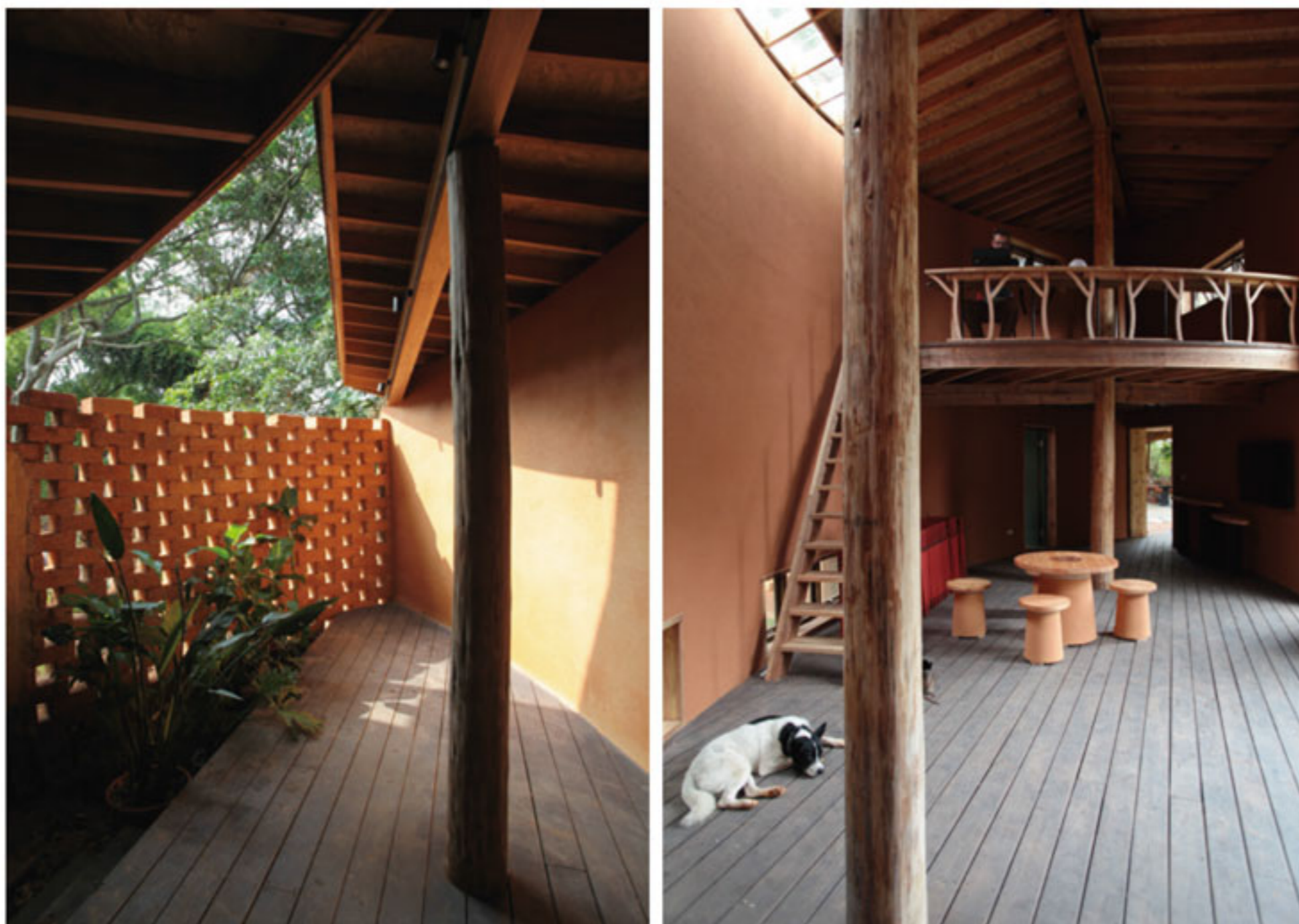
「四口之家」利用廢棄的稻桿製成隔熱效果佳的預鑄牆，讓建材取自大自然，也容易回歸大自然。
