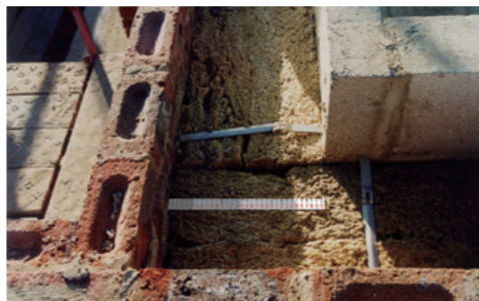
社區地底留有儲存雨水與傳送能源加熱的暖水管道，以達到環保永續的低碳理想。
