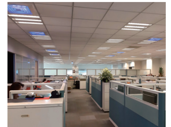
▲「可見光光觸媒過濾器」加裝在中央空調出風口，達到抑菌、除臭、自潔等效果，降低辦公空間傳染機會。
