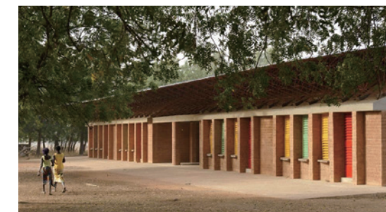
圖五：甘多小學運用黏土磚製作，具有通風、隔熱效果。(圖源Kéré建築工作室官網)
