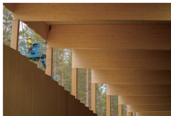
膠合木材料，成為園區建築結構的主要材質。
