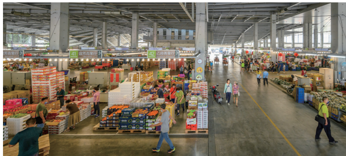
06 開放式的大跨距挑高設計，讓作業區擁有良好通風，顛覆以往傳統果菜市場窠臼。
