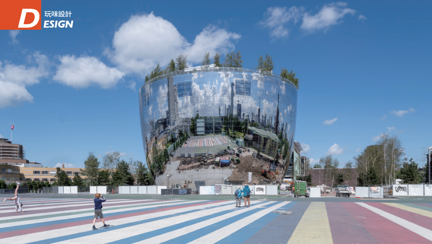
01_高達39.5公尺高的建築體，由鏡面玻璃帷幕，反映出周圍的地景地貌。
