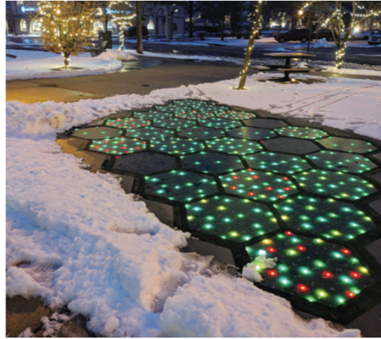
鋪設在路面的太陽能板可透過發熱機制，為嚴寒氣候地區省去剷雪、除冰的困擾。
